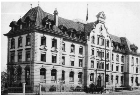
Das Schülerhaus kurz nach der Fertigstellung ca. 1905
